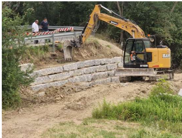
Ricostruzione scarpata di via Tizzano
